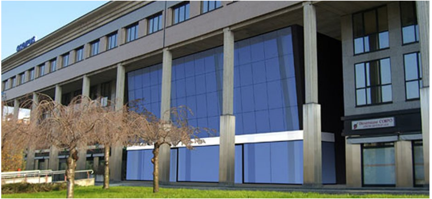
Nueva sede de Nova Systems en Milan.
