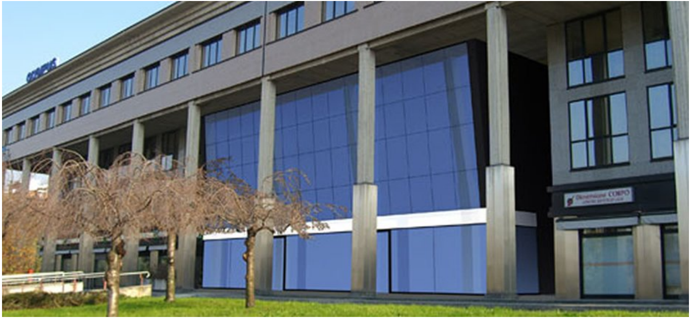
Nueva sede de Nova Systems en Milan.
